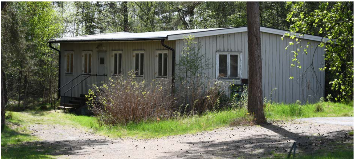
Expeditionsbyggnaden, byggnad 3, ligger vid sidan av kanslihuset. Den låga enplansvolymen är i gott skick förutom fönsterluckorna som saknas sedan länge.
