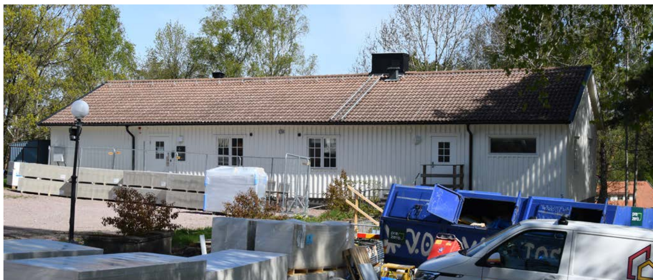
Officersbostaden, byggnad 226, ligger uppe vid officersmässen i samma område som kanslihus och flygledartorn. Byggnaden är delvis ombyggd till expedition.
