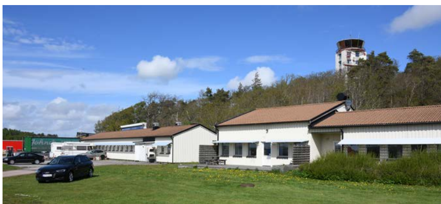
Byggnad 99, 3 divisionen divisionsbyggnad (närmast i bild) och byggnad 102, 2 divisionens flygtjänstbyggnad (längst bort i bild).
