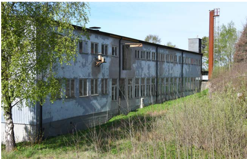
Säk.mat.verkstad (byggnad 116) med förråd och värmecentral. Framsidan är plåtklädd, baksida och ena gaveln har kvar sina putsade fasader.
