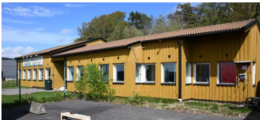
Byggnad 98, 2 divisionen divisionsbyggnad innehöll ordersal, rum för flygförare och administrativa utrymmen.
