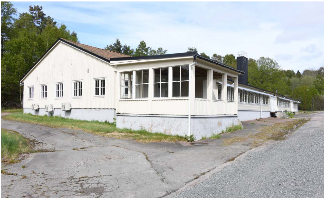
Likheterna med verandan på byggnad 62, underofficersmässen, är slående även om denna variant är något större och sticker ut över hörnet. Byggnadens nuvarande helt vita kulör är senare tillkommen liksom de svarta plåtdetaljerna. Jämfört med marketenteriet (motstående sida) som har kvar en mer original färgsättning, är matsalen mer slätstruken i sitt uttryck.
