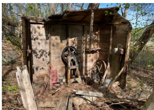
Endast rester återstår efter pumphuset vid Officersmässen.
