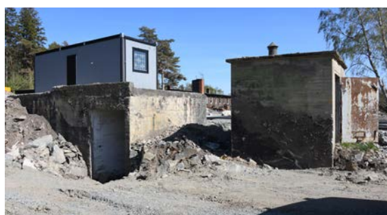
Betongfundamentet till vattenreservoaren finns kvar och liksom även vissa av pumparna som stod för trycket i flottiljens ledningssystem.
