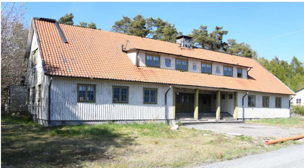
Manskapsmäss och marketeriet, byggnad 63. Indraget entréparti med pelare, taklyft med spröjsade fönster. Sköldarna tillkom då byggnaden användes av hemvärnet.
