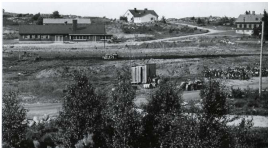
Bild från Säve i maj 1941, under anläggandet av idrottsplanen. Den mörka byggnaden med långsidan mot karmeran är matsalen, och bakom den ligger den så kallade "Pigholken", alltså bostaden för den kvinnliga kökspersonalen. Den ljusa byggnaden på krönet är underofficermässen, och till höger ligger sjukstugan. Bild ur: Kungl. Göta flygflottilj 1940-69, s. 19
