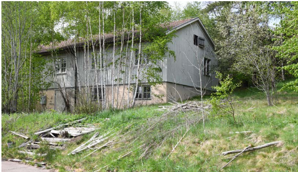
Den så kallade "Pigholken" var bostad för mässens kvinnliga personal. Byggnaden har nummer 221.
