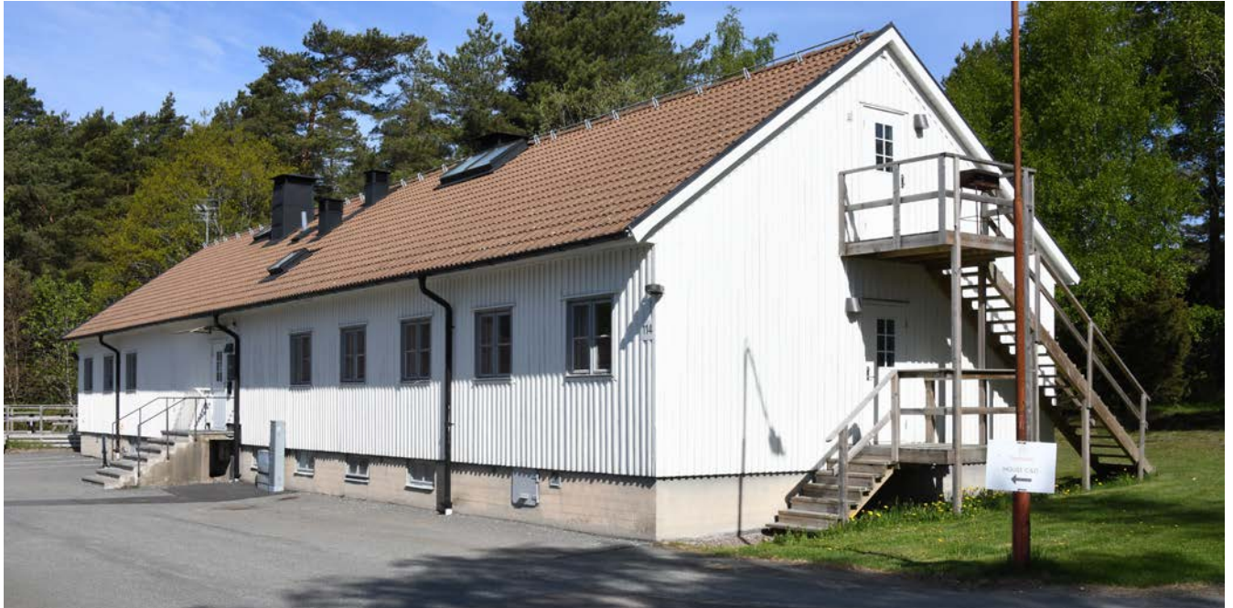
Byggnad 28, 4 divisionens kasern. Stora delar av exteriören är bevarad i sitt ursprungliga utförande med locklistpanel, spröjsade fönster och den karakteristiska trappan. Fönsterluckorna är borta sedan länge men bortsett från den vita kulören som är sentida är detta den mest välbevarade av alla kasernbyggnader i området.
