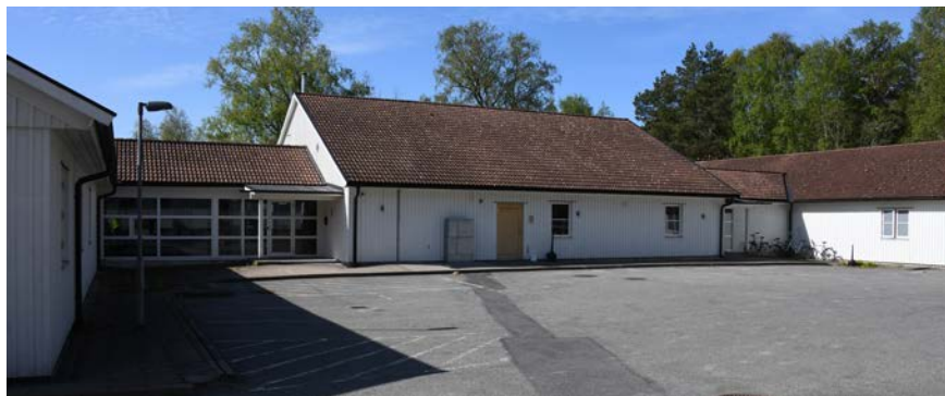
Byggnad 55 byggdes 1995, och ersatte äldre kasernbyggnader på samma plats. Idag används byggnaderna av ett företag som hyr ut lägenheter till långtidsboende.
